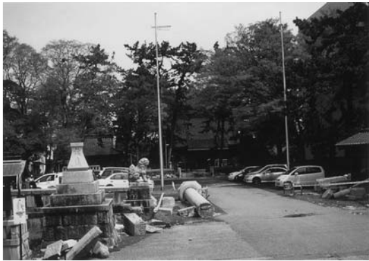
Photo 2 Damage to Juzo Sinto shrine by the 2007 Earthquake, Wajima. 写真 2 輪島市内重蔵神社 (2007年4月23日)
