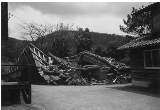
Photo 3 Crashed houses of Monzen Town, Wajima. 写真 3 門前町の家屋の崩壊 (2007年4月23日)
