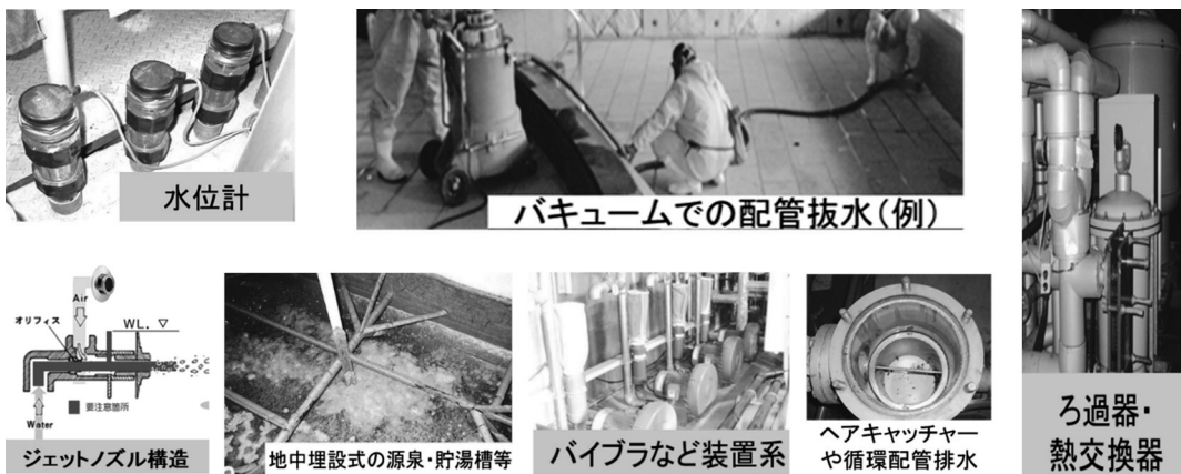
図 10 水の排水や抜水のし難い箇所の例
