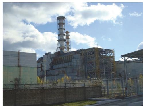
図1 2012年10月時点における石棺で覆われたチェルノブイリ原子力発電所4号炉。
