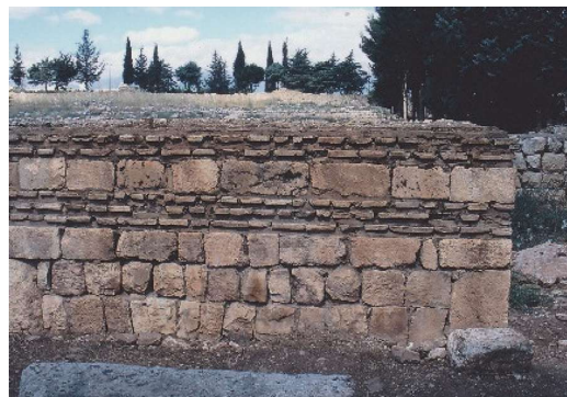
図 2-8 アンジャールの地震対策の石積 大山 2005 年 8 月 8 日撮影.
