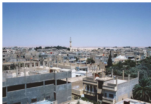
図 2-25 パルミラは降雨がほとんど無いので屋根は 平らの陸(ろく)屋根 大山 2005 年 8 月 10 日撮影
