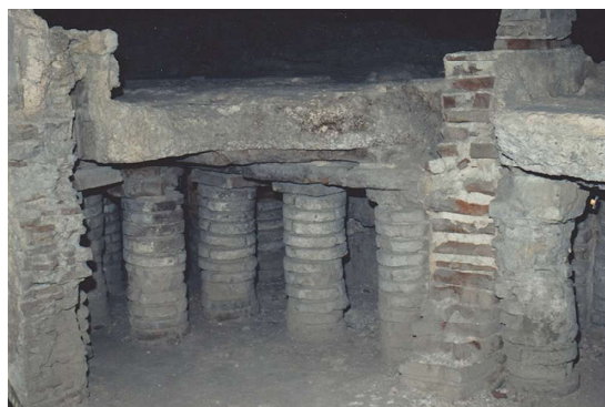
図 7-12 共同浴場の床下暖房装置の遺構。 フランス東部の温泉地エクス・レ・バン 大山 1995 年 5 月 7 日撮影
